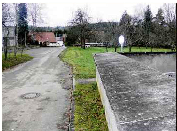
Im Reumorgenweg beim Endinger Friedhof sollen neue Bauplätze erschlossen werden. Foto: Hauser
