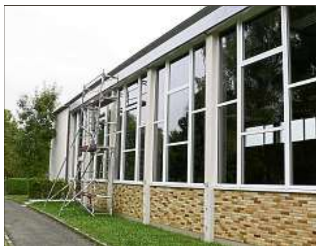
Das Gerüst an der Endinger Halle wurde für Statik-Berechnungen benötigt. Wie es mit der Sanierung weitergeht, steht noch nicht fest.
