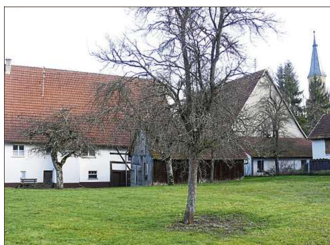
Mitten in Endingen sollen bald vier Wohnhäuser gebaut werden. Dafür muss ein altes Bauernhaus weichen. Foto: Hauser
