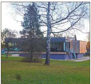
In unmittelbarer Nähe zum Weilstetter Lochenbad soll die Senioreneinrichtung gebaut werden. Foto-Archiv: Hauser
