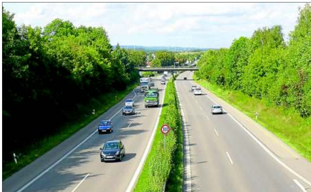
Ob die B 27 durchgängig vierspurig ausgebaut wird, stellen die geplanten Kürzungen in Frage. Foto: Ungureau
