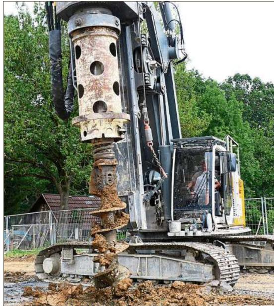
Mit einer Spezialmaschine werden bereits Löcher für die Betonpfeiler gebohrt.
