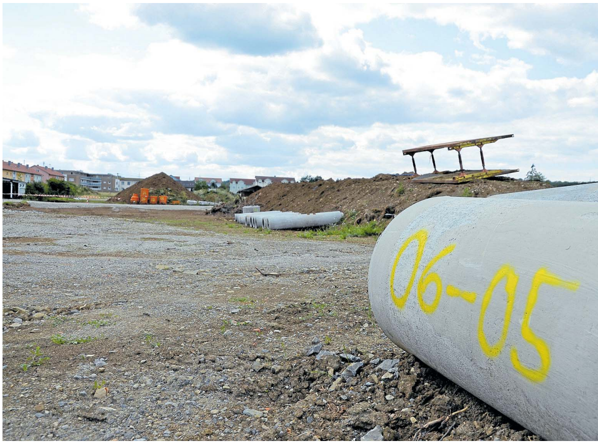
Die Straßen im neuen Baugebiet Urteilen sind schon geschottert. Derzeit werden die Rohre und Leitungen verlegt. Im Jahr 2019 soll mit dem Bau der Häuser begonnen werden. Foto: Lydia Wania-Dreher
